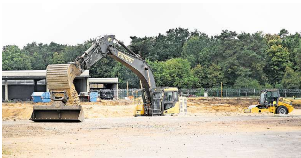
Die Vorbereitungen laufen: Bald können die Arbeiten an den Neubauten bei der Fliegerstaffel Gifhorn beginnen. Foto: Sebastian Preuß
