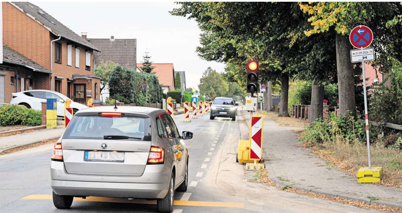
Eine der Baustellen im Landkreis: In Abbesbüttel wird die Ortsdurchfahrt saniert.
