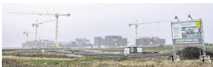
Das Baugebiet Sonnenkamp: Hier soll weiterer Wohnraum entstehen.
