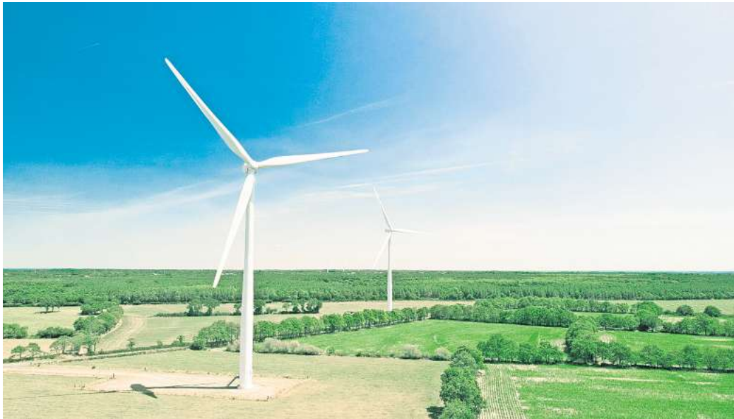
Klimafreundliche Energie: 409 moderne Windräder mit einer Gesamtleistung von 2,2 Gigawatt gingen 2024 ans Netz – so viel wie seit 2017 nicht mehr.
