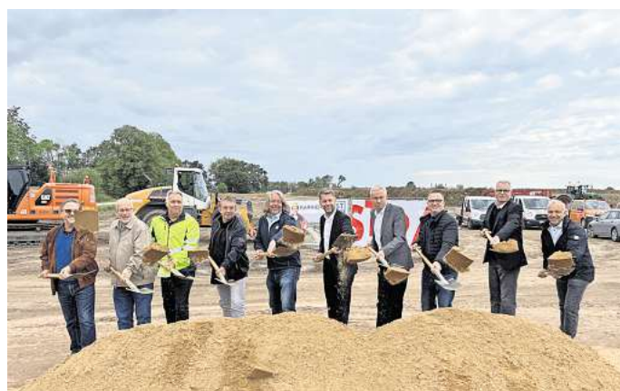
Oberbürgermeister Dennis Weilmann (6. v. l.) und Kai-Uwe Hirschheide, Erster Stadtrat und Stadtbaurat (7. v. l.) setzten gemeinsam mit Vertretern aus Politik und Verwaltung den ersten Spatenstich für den Bauabschnitt Süd 1 der Alternativen Grünen Route (AGR). FOTO: STADT WOLFSBURG
