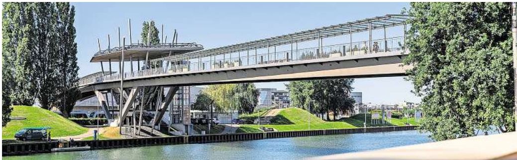
Die Sanierung der Stadtbrücke befindet sich auf der Zielgeraden.
