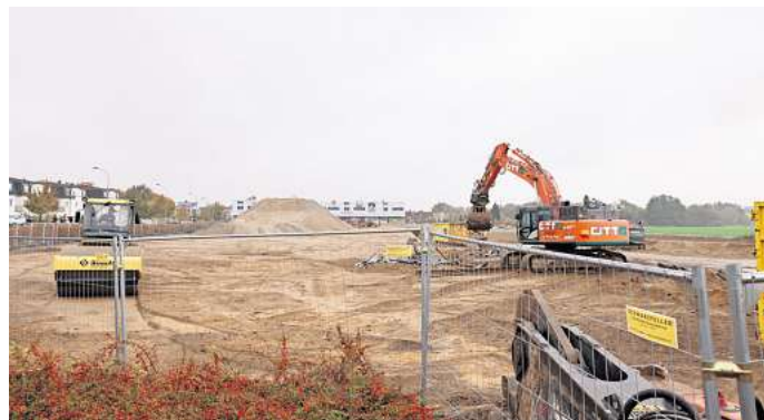
Baugrund ist vorbereitet: Im November erfolgt der erste Spatenstich für einen neuen Supermarkt in Nordstemke. FOTO: ROLAND HERMSTEIN
