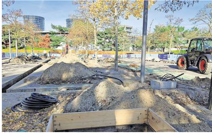
Großbaustelle an der Autostadt: Auf dem Kurzzeitparkplatz unter der LED-Leinwand (Bild) und hinter dem Parking-Häuschen entstehen moderne Ladeparks für Elektroautos. FOTO: CARSTEN BISCHOF
