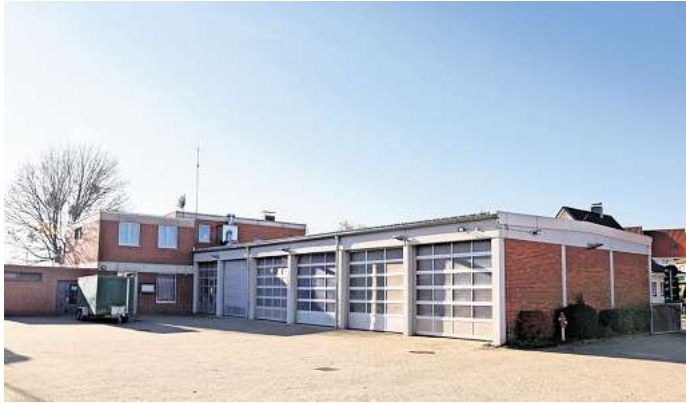
In Vorsfelde soll die Feuerwehr einen Anbau bekommen.
