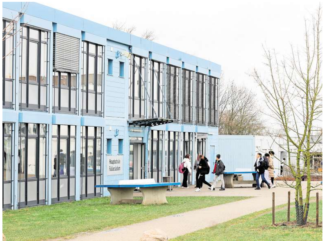
Platznot: Wegen steigender Schülerzahlen wird bei der Hauptschule Fallersleben gerade angebaut.
