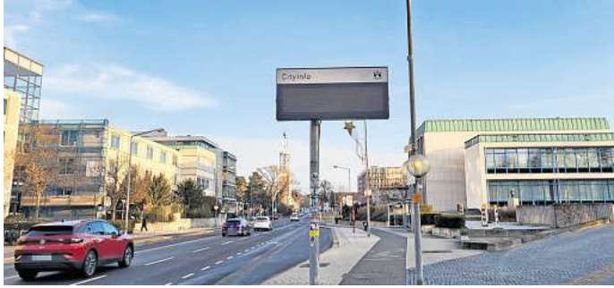
Die Stadt Wolfsburg hat mit der Installation des neuen CityInfo-Systems begonnen. Die Tafel an der Pestalozziallee ist aber noch nicht in Betrieb. FOTO: OLIVER FRICKE
