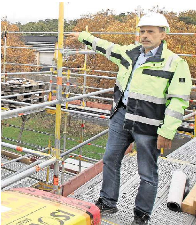
Dr. Christian Brinsa auf der Baustelle der neuen Leonardo-da-Vinci-Grundschule im Oktober 2025.
