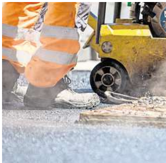
Die Bauarbeiten in Neuhaus gehen gut voran. FOTO: FLORIAN GAERTNER
