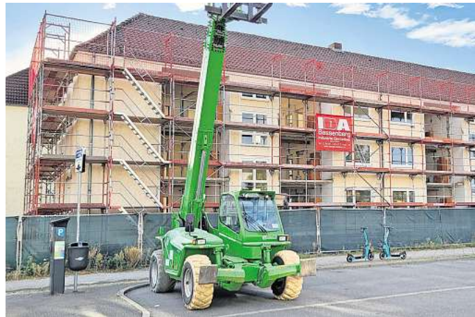
Auf dem Wohnungsmarkt tut sich in Wolfsburg einiges: Beispielsweise in der Straße „Am Mühlengraben“ saniert die Neuland im Bestand und erweitert die Wohnfläche durch den Ausbau des Dachgeschosses.
