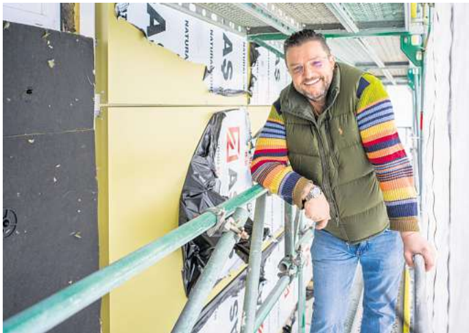
Blick zur goldenen Fassade: Nach Angaben von Investor Teja Schönberger sollen demnächst 60 Prozent der neuen Hochhaus-Optik fertig sein.
