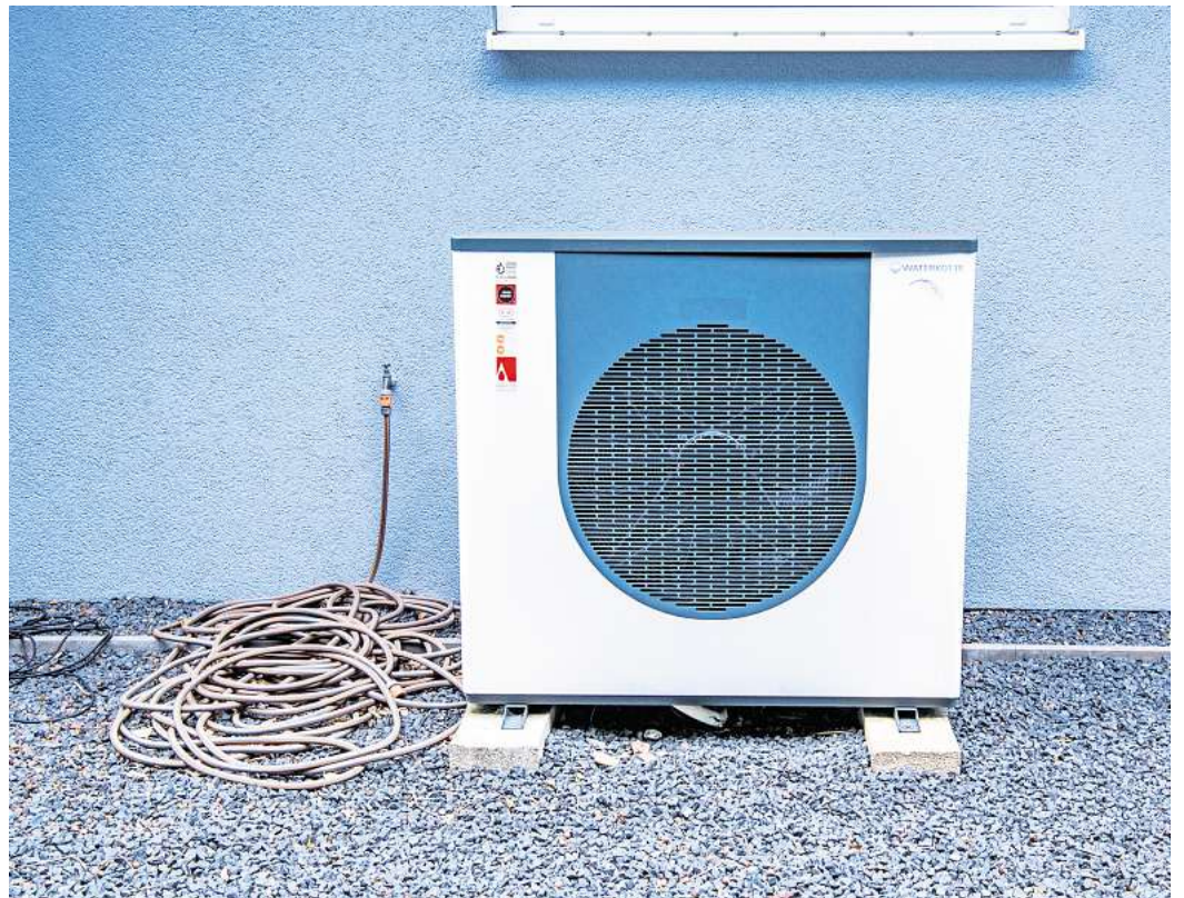
Moderne Wärmepumpen sind leiser als früher: Mit unter 50 Dezibel arbeiten sie so leise wie ein Geschirrspüler.
