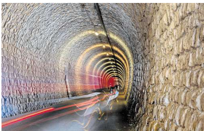
Der Bahntrassenweg führt auch über Brücken und durch dunkle Tunnel wie hier im slowenischen Strunjan. FOTO: IMAGO IMAGES/POND5 IMAGES
