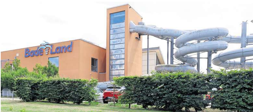
Das Badeland in Wolfsburg hat Sanierungsbedarf.
