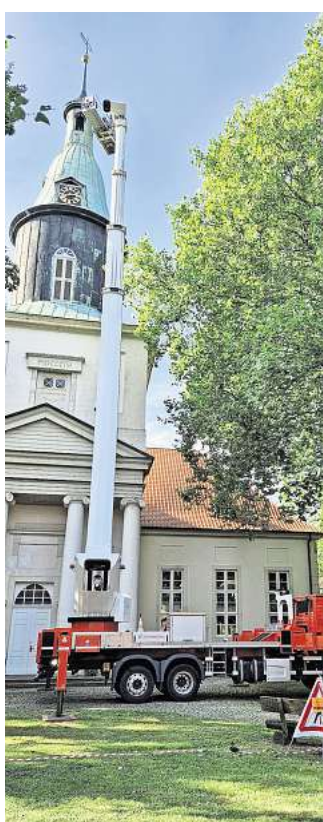
Der Hubsteiger im Einsatz.
