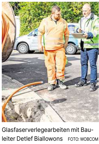
Glasfaserverlegearbeiten mit Bau- leiter Dettlef Biallowons FOTO: WOB COM
