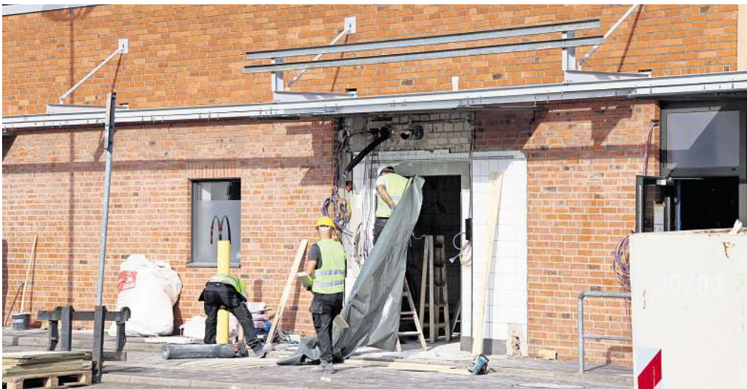
Großbaustelle: Die McDonald's Filiale an der Dieselstraße Ecke Lerchenweg, wird in den nächsten Wochen modernisiert.
